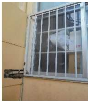
Σχεδόν όλα τα παράθυρα του συγκροτήματος είναι παλιά από αλουμίνιο, μονά, με ανάκληση από κατασκευής των κτιρίων (1973)
