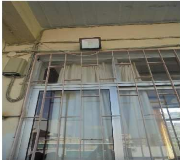
Σχεδόν όλα τα παράθυρα του συγκροτήματος είναι παλιά από αλουμίνιο, μονά, με ανάκληση από κατασκευής των κτιρίων (1973)
